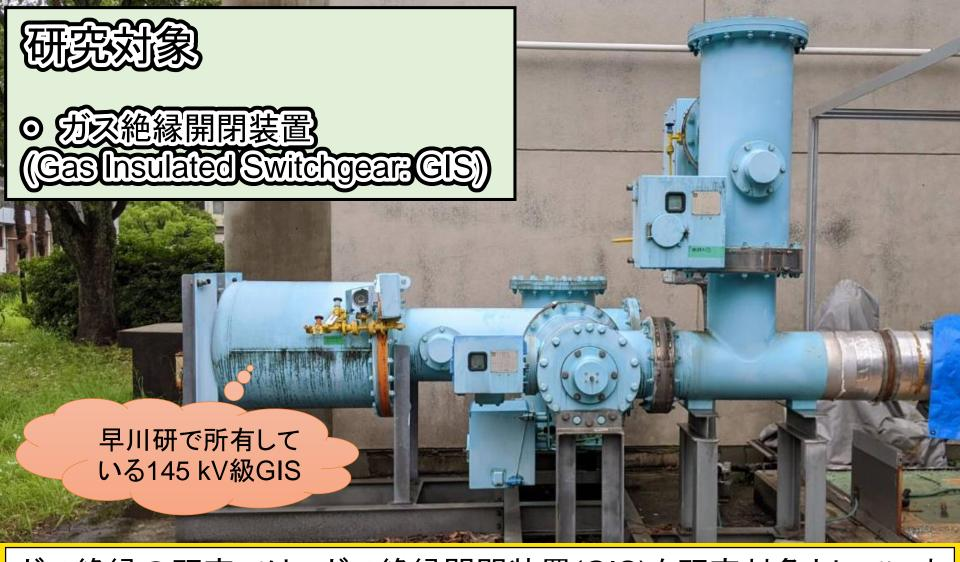
ガス絶縁の研究では、ガス絶縁開閉装置(GIS)を研究対象としています。GISは電力系統においてスイッチのような役割を果たす機器で、雷が落ちても家が停電せずに済むのはGISのおかげです。GISは内部で放電しないように、中に絶縁ガスを封入しています。
